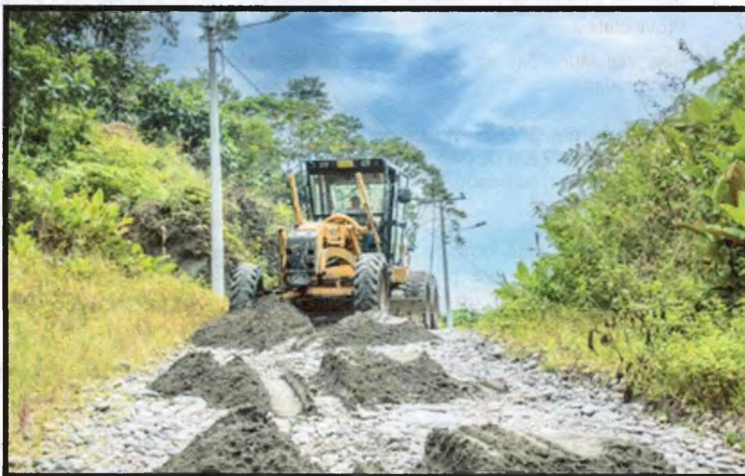
Fotografía.- mantenimiento vial.- maquinaria pesada
