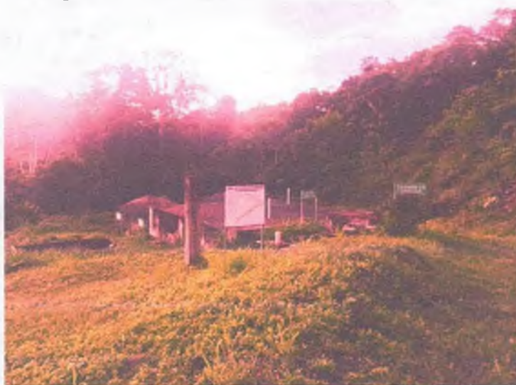
Fotografía: PLANTA DE TRATAMIENTO EXISTENTE
