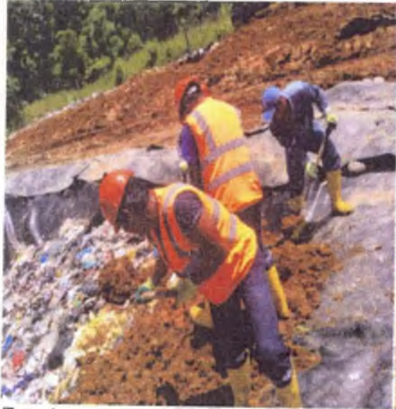
Tapado con material arcilloso y compactación de los desechos sólidos en la celda de disposición final.
