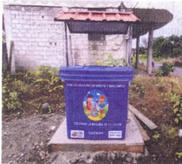
Colocación de Contenedores fijos estacionarios de 660 lts y 55 gal en la cabecera cantonal.
