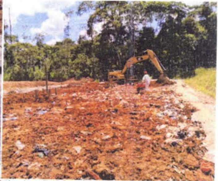
Tapado con material arcilloso y compactación de los desechos sólidos en la celda de disposición final.
